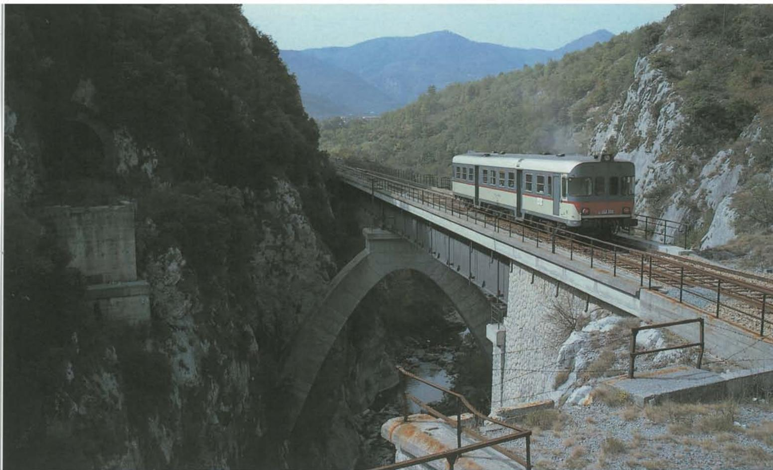
**Foto 2.10:** sulla diramazione SNCF Breil-Nizza della linea di Tenda i treni in servizio diretto Torino-Nizza sono effettuati da automotrici FS. L'ALn 668.1100 supera il 10 ottobre 1979 il fiume Bevera sul viadotto di Cal; da notare l'arcata di sostegno perpendicolare. Espresso Torino-Nizza presso Sospel.
