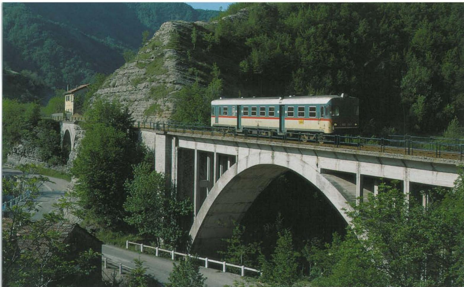
**Foto 4.20:** nel corso degli anni, la Faentina ha subito svariati ammodernamenti, come questo ponte in cemento nei pressi di Crespino del Lamone, dove la linea attraversa in un sol balzo un affluente del Lamone, parallelamente alla strada statale, realizzato, come cita la scritta che capeggia sullo stesso, nel 1957. E' in transito l'ALn 668.1934 come locale 10701 Firenze-Faenza.
